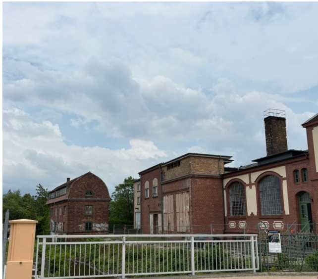
Abbildung 5: Möglicher Taubenschlag auf dem Dachboden des Gebäudekomplexes E-Werk
